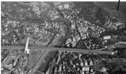
Viadotto sopra le aree ferroviarie di Trasta
