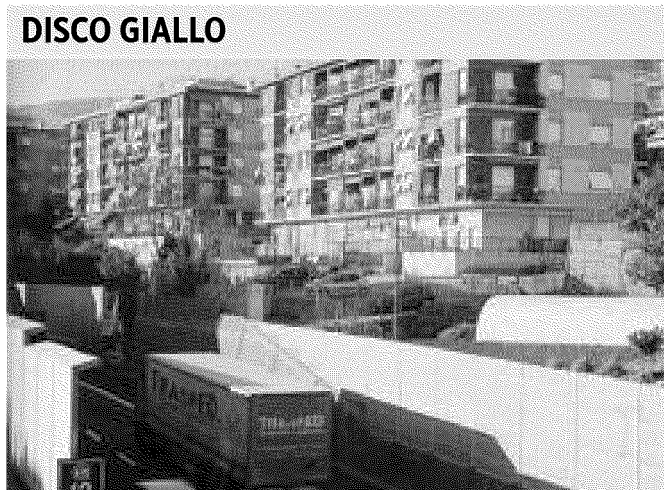
L'autostrada A10 nella zona in cui attraversa Palmaro
